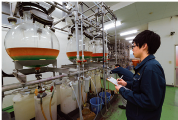
東京工場溶媒抽出設備
