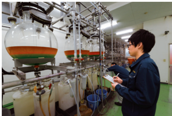
東京工場溶媒抽出設備
