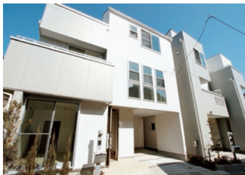
世田谷区祖師谷一丁目A号棟 外観
