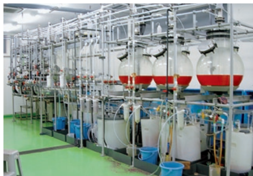
東京工場溶媒抽出設備
